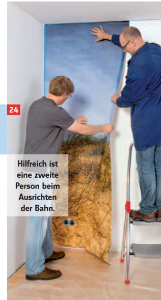
21 Jetzt Kleister für die nächste Bahn auftragen, stets etwas breiter als Bahnenstärke. Kleister auf bereits tapezierten Flächen ...
