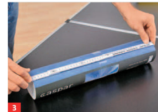
3 ... die erste Bahn mit einem Überstand von 5 cm an die Wand. Bei geraden Wänden wie hier überträgt man die ...
