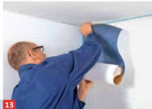
13 ... aufrollen. Setzen Sie die Bahn an der markierten Linie an, entweder wandbündig oder mit 5 cm Überstand, in jedem ...
