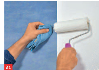
21 Jetzt Kleister für die nächste Bahn auftragen, stets etwas breiter als Bahnenstärke. Kleister auf bereits tapezierten Flächen ...
