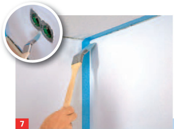
7 Vliestapeten lassen sich im Wandklebverfahren verarbeiten. Zunächst in Ecken und rund um Dosen Kleister auftragen.
