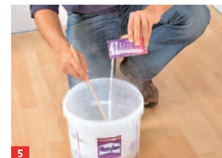
5 Kleister für Vliestapeten anrühren, z.B. Metylan Direct. Ca. vier Minuten ruhen lassen, dann nochmals durchrühren.
