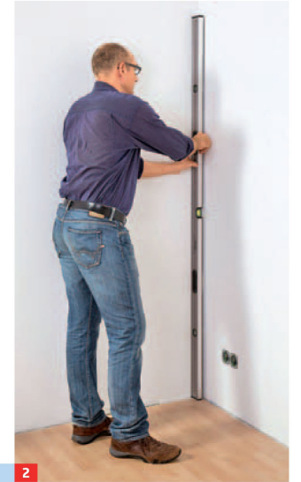
2 Mit der Wasserwaage können Sie prüfen, ob Ihre Wände lotrecht verlaufen. Ist das nicht durchgängig der Fall, setzt man ...
