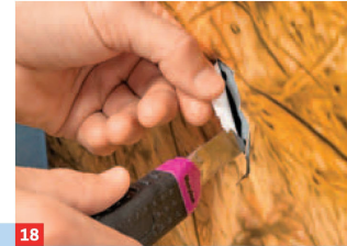
18 An den eingerissenen Stellen kann man nun den Cutter gut ansetzen und die Dose sauber freischneiden.
