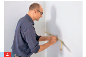
4 ... Bahnenbreite 1 zu 1 ohne Zugabe auf die Wand und macht sich dort einen Strich, um die Bahn gut ansetzen zu können.
