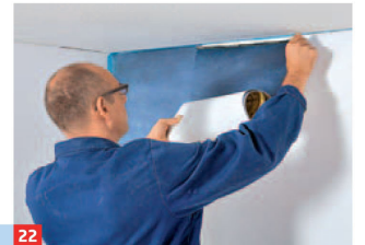
22 ... direkt wieder aufwischen! Bahn Nr. 2 oben ansetzen, auf Stoß zur ersten Bahn. Nun auf den Motivverlauf schauen ...
