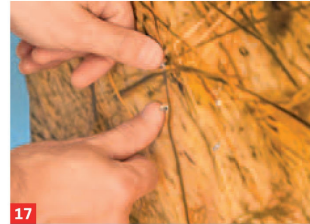
17 Steckdosen zunächst übertapezieren. Die spannungsfreie Dose dann ertasten und die Tapete dort etwas eindrücken.
