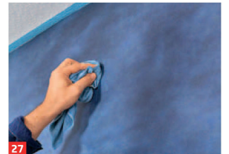
27 Achten Sie darauf, heraustretenden Kleister, z.B. im Nahtbereich, direkt aufzuwischen; Lappen regelmäßig ausspülen!
